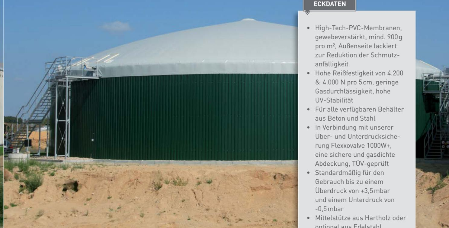
Das Standard-Silodach mit integrierter gasdichter Folienlunge speichert Gase, die aus sämtlichen organischen Substraten gewonnen werden. Die gasdichte Klemmung erfolgt an der Innenseite des Behälters.
