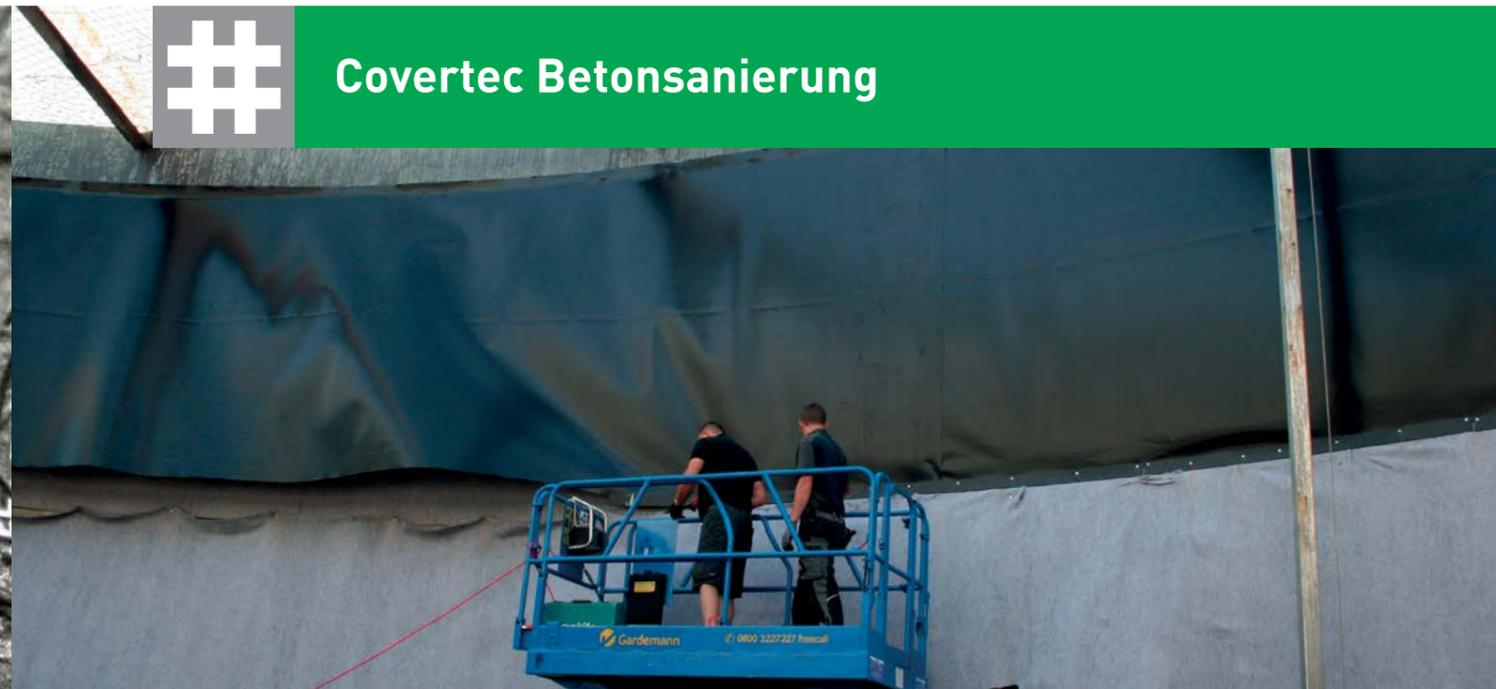
Betonbehälter und auch Fahrhilfwände unterliegen einer biochemischen Korrosion. Dabei können je nach Qualität des Betons eine Porosität oder auch Haarrisse entstehen. Auch Schutzanstriche können mit der Zeit durchlässig werden. Hier bietet sich eine nachträgliche Betonsanierung an, um die Innenwände von Behältern zu schützen.
