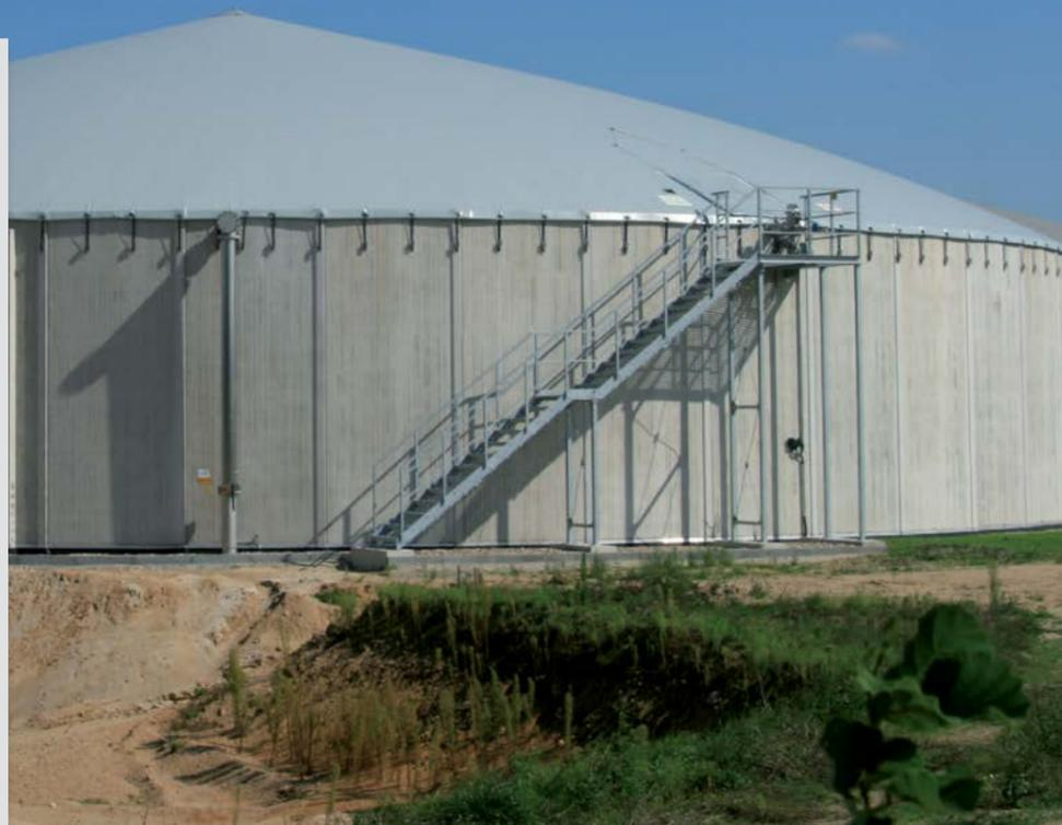
Bei dieser Standard-Dachkonstruktion handelt es sich um eine einschalige Abdeckung für Fermenter, Nachgärer oder Endlager zum Auffangen und Verwerten von Restgas und der gleichzeitigen maximalen Geruchsreduzierung. Die gasdichte Klemmung erfolgt an der Innenseite des Behälters.
