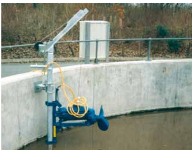
Tauchmotorrührwerk GTWSI 1040 im Schlammstapelbehälter einer Kläranlage
