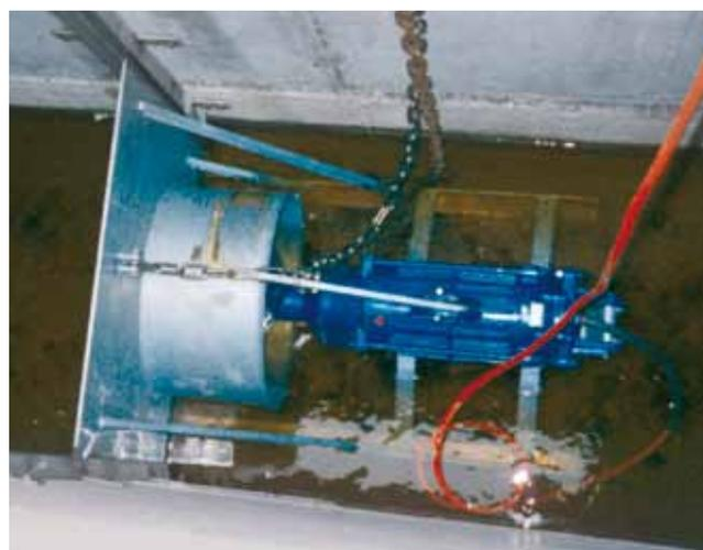
Tauchmotorrührwerk in Ringkanalsystem
